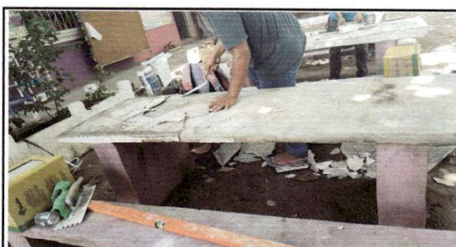
Foto 6: Instalación de azulejos en mesas de concreto
