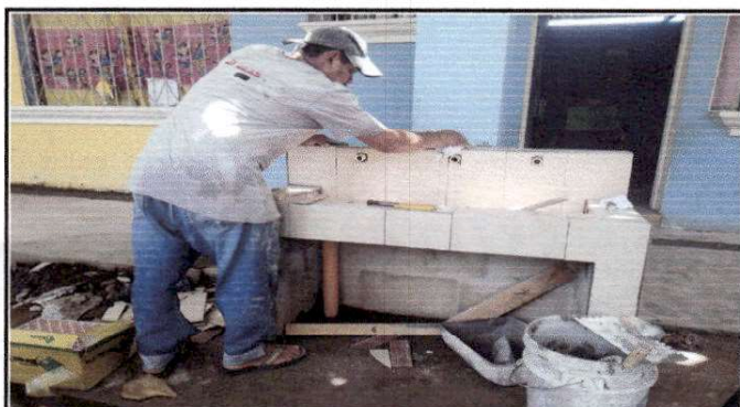
Foto 3: Sustitución de llave de chorro
