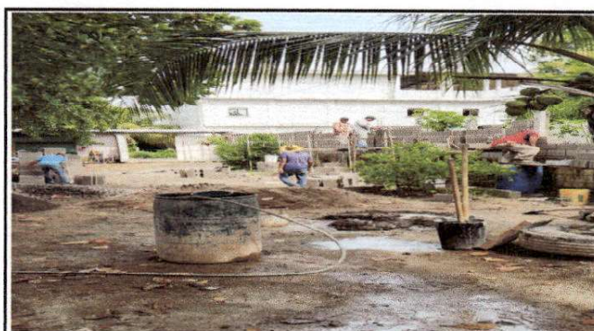
Foto 4: Reparación de muro perimetral de block
